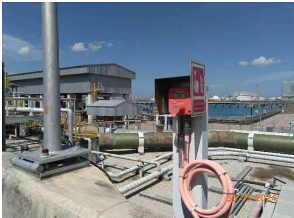
รูปที่ 2-45 อุปกรณ์แจ้งเหตุฉุกเฉิน (Manual Call Point) บริเวณท่าเทียบเรือ
