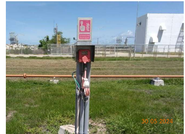
รูปที่ 2-47 อุปกรณ์แจ้งเหตุฉุกเฉิน (Manual Call Point) ภายในพื้นที่โครงการ
