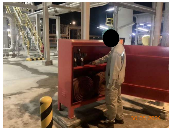
รูปที่ 2-49 การตรวจสอบอุปกรณ์ดับเพลิงประจำเดือน
