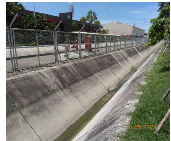
รูปที่ 2-13 ระบบระบายน้ำฝนภายในพื้นที่โครงการ
